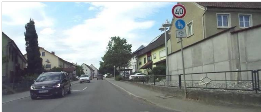
Abbildung 13: Lärmschutzwand Ecke Singener Straße / Lange Straße
