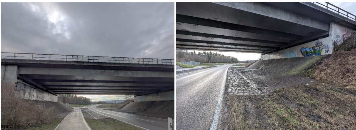
Abbildung 47: Unterführung an der B33 im Süden von Steißlingen
