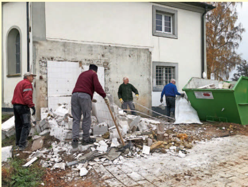
Freiwillige Helfer bei der Entsorgung des Bauschutts
