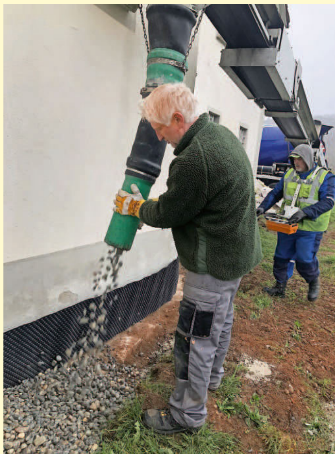
Einbringen von Sickerkies zur Trockenlegung der Fundamente
